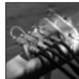
Accrochage des connexions hydrauliques
